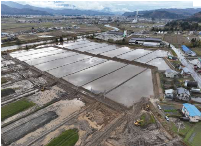
・ 圃場整備 東中地区第2次工事(魚沼市東中地内)
