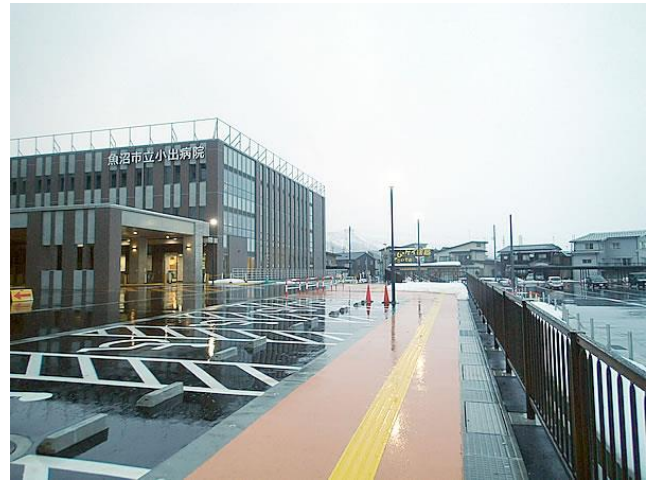
・市立小出病院外構工事(3期)(魚沼市日渡新田地内)
