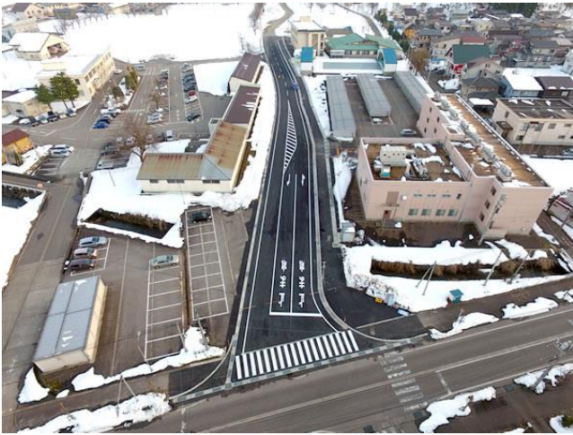
・市道袖八大塚線道路改良工事(1工区)(魚沼市小出島地内)
