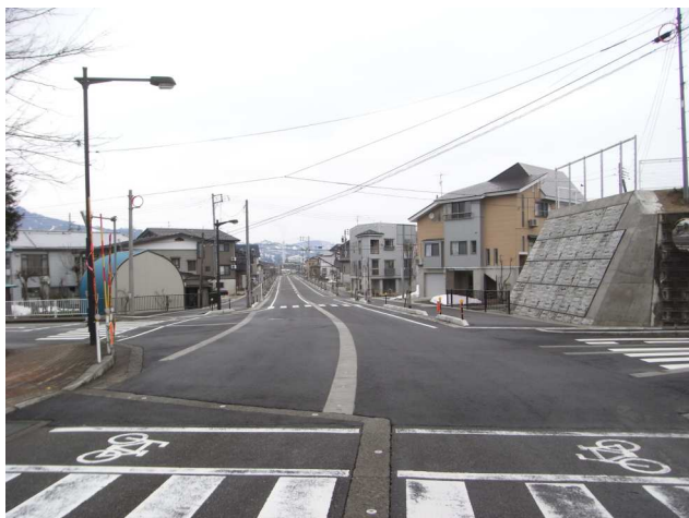
・小出広神線 道路改良工事（魚沼市小出島地内）
